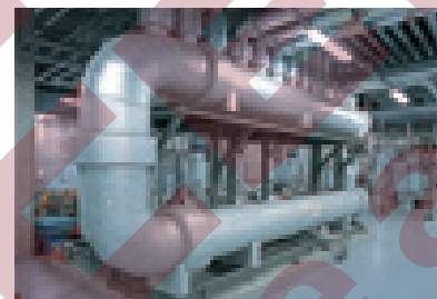
Система теплообмена, использующая тепло от электрического генератора, охлаждает оборудование для литья под давлением.
